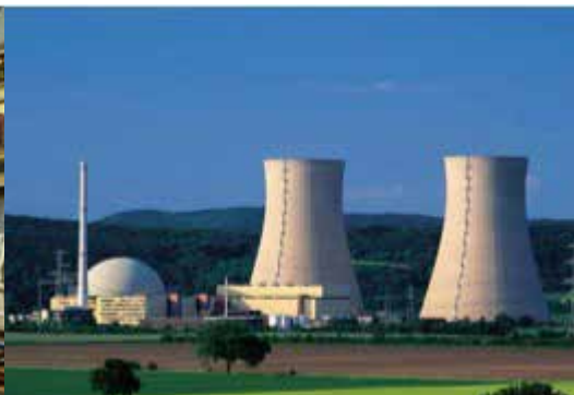
E.ON Kernkraft GmbH - Germany
